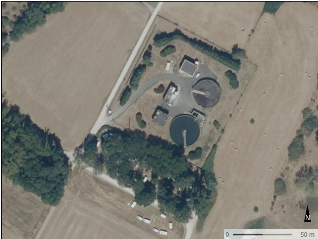
Figure 2 : Vue aérienne de la station d'épuration (source : Photographie aérienne - Géoportail)
